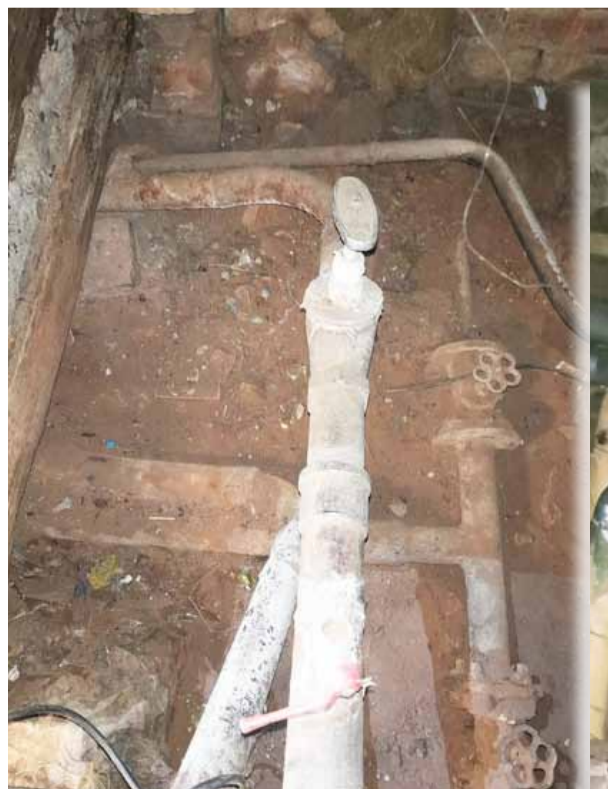
Замена труб и запорной арматуры на вводе в доме пер. Парковый, 3
