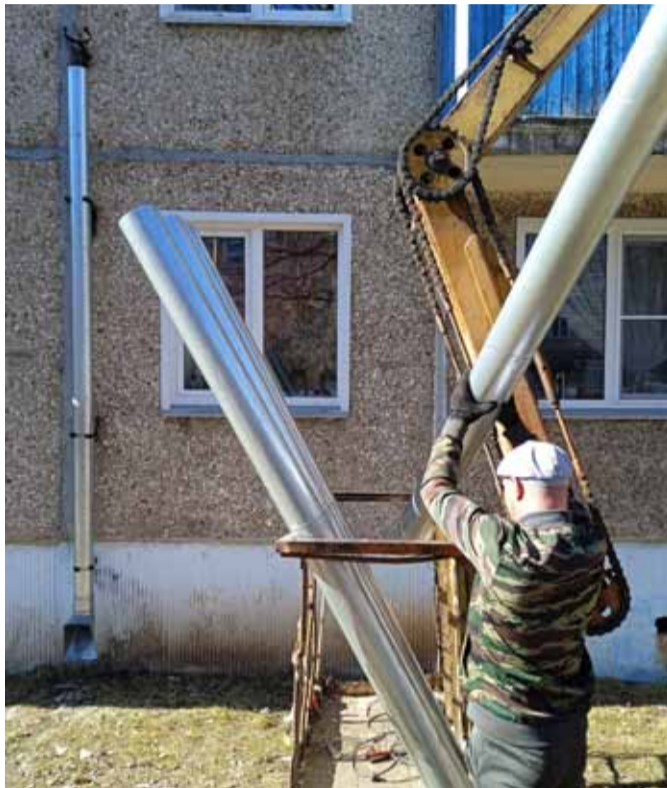
Капремонт кровли ул. Ленина, 20А. Апрель 2023
