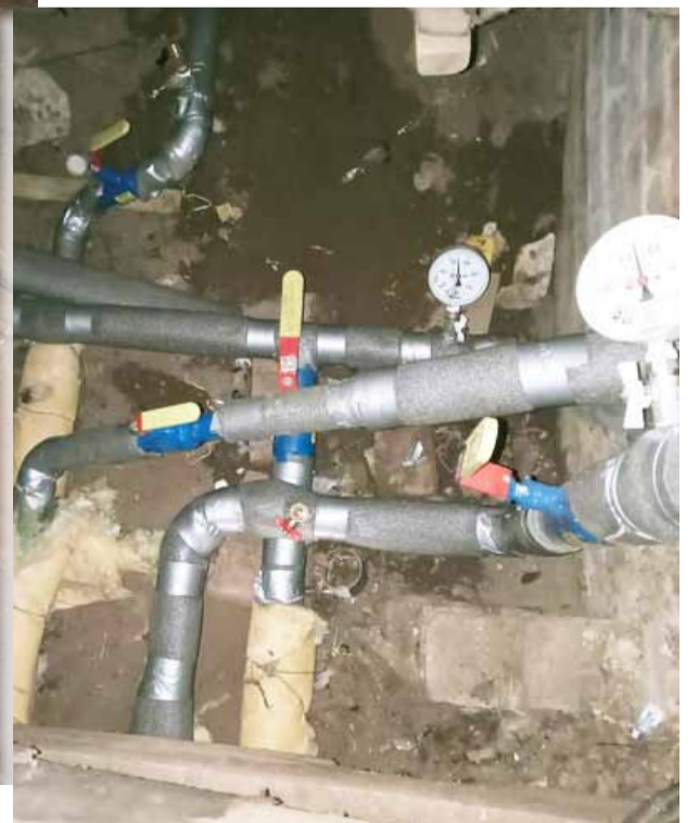
Замена труб и запорной арматуры на вводе в доме пер. Парковый, 3
