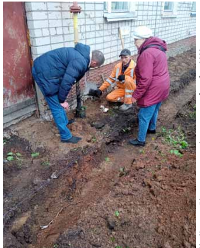
Ул. Кирова, 59 — капремонт фундамента. Октябрь 2022
